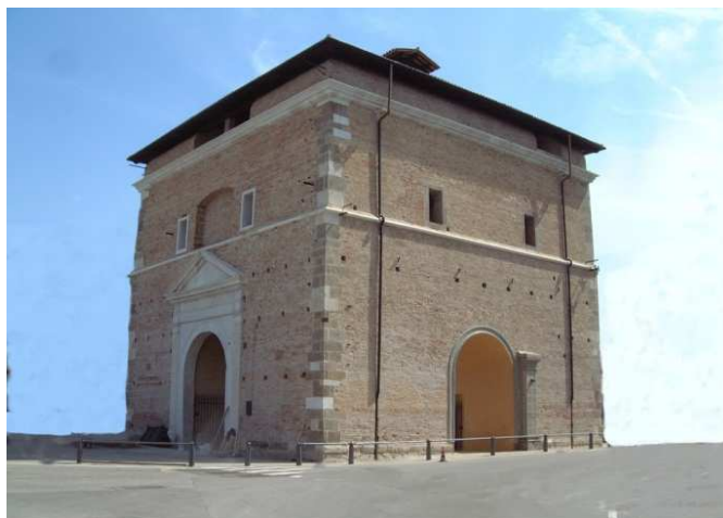
Porta Pontecorvo - Padova - Sede Progetto Ponte
